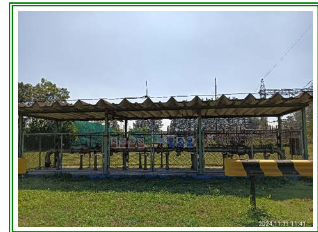
รูปที่ 3-11 ท่อส่งก๊าซธรรมชาติ เพื่อใช้เป็นเชื้อเพลิงสำหรับเตาอบเหล็กและกระบวนการรีดเหล็ก
