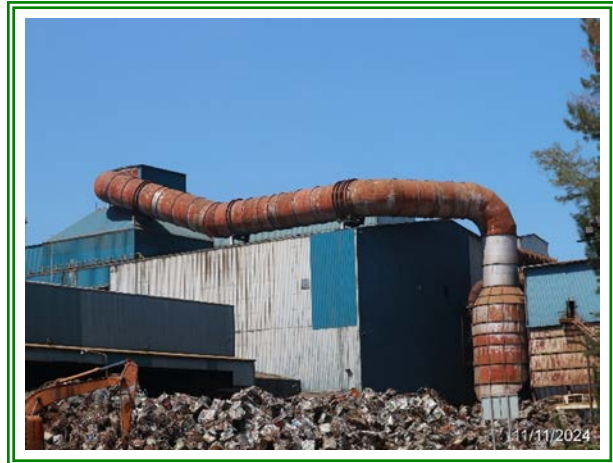
รูปที่ 3-14 ระบบดักฝุ่นแบบ Canopy Hood ที่ใช้ดูดฝุ่นละอองและ Fume ที่ล้าเลียงเข้าไปบำบัดโดยผ่านระบบดักฝุ่นแบบถุงกรอง (Bag Filter)
