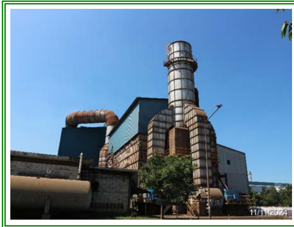
รูปที่ 3-14 ระบบดักฝุ่นแบบ Canopy Hood ที่ใช้ดูดฝุ่นละอองและ Fume ที่ล้าเลียงเข้าไปบำบัดโดยผ่านระบบดักฝุ่นแบบถุงกรอง (Bag Filter)
