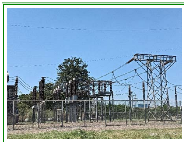
รูปที่ 3-42 สถานีไฟฟ้าย่อย 1 (Sub Station 1) สำหรับจ่ายไฟฟ้า ให้กับโรงหลอมและโรงรีด
